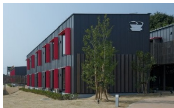
CLT工法による木造ホテル
