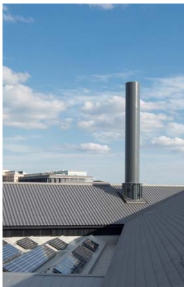
煙突全景と太陽光パネル
