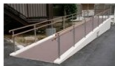
スロープの設置
