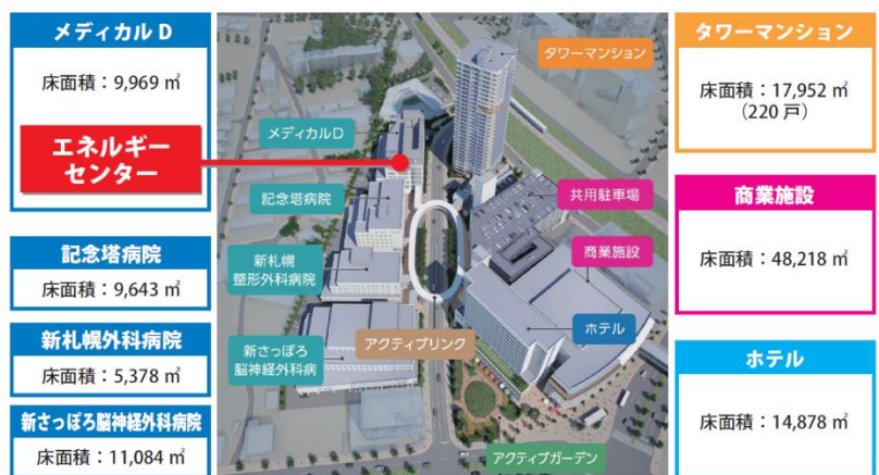
図1 新さっぽろI街区全景
