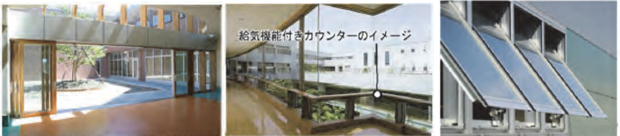
①フルオープンサッシ（木複合断熱サッシ）②家具と組み合わせた給気カウンター
