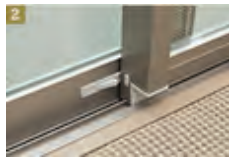
2 防犯に配慮しながら換気できる 自然換気ストッパー付きサッシ
