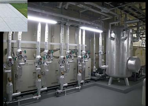
地中熱利用ヒートポンプシステム
