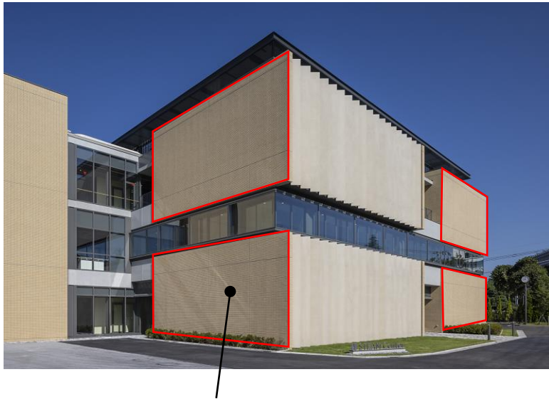
外壁面に井水循環パイプを埋設
