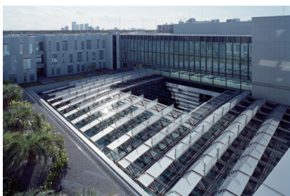
日射負荷の低減を意図したルーバー配置としたボイド頂部の遮蔽ルーバー 写真:小川泰祐
