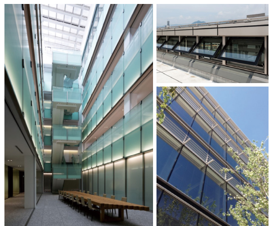
自然換気窓とコミュニケーションボイドを利用した自然換気計画
