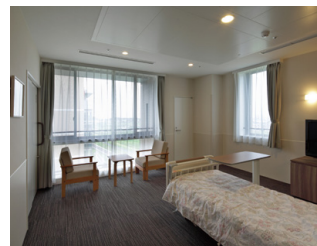
天井や床に放射冷暖房システムを採用
