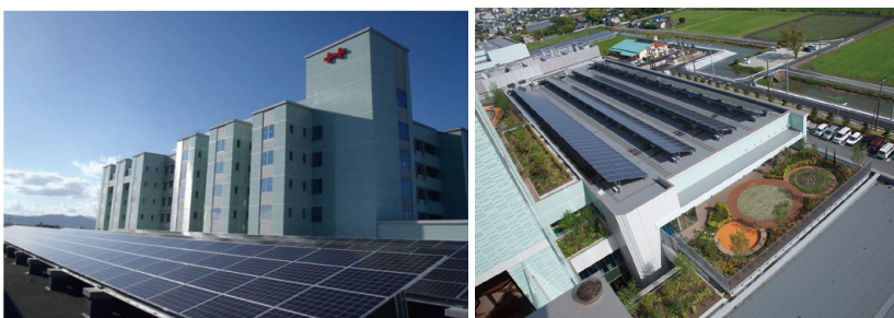
病院低層部の広い屋根面を活用して全面的に太陽光パネルを設置
