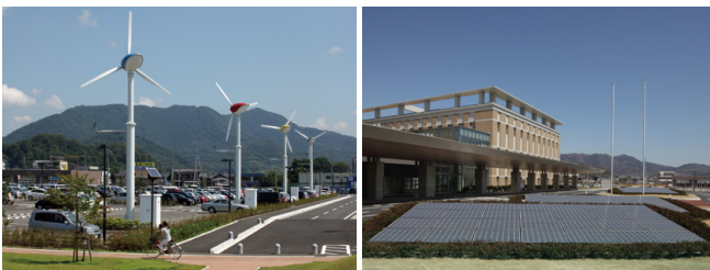
トリアーじカラーに塗られた風力発電と、来院者へのエコ啓発となる地表面に設置した太陽光パネルの設置
