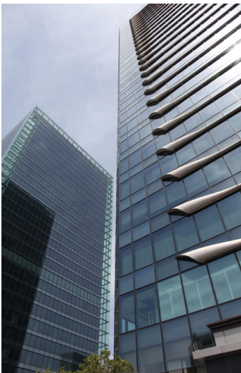
エアインテイクによる通風換気をファサードデザインに採用
