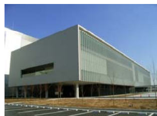
事務棟外観の日射遮蔽フィン
