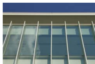
西側外壁のフィン部分
