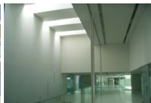
トップライト・吹抜部分
