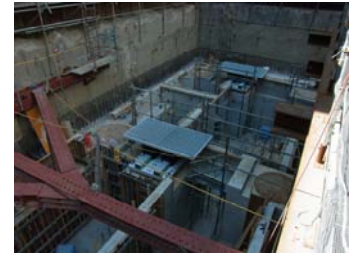
[免震装置取付状況]
