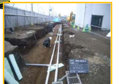
ボアホール設置工事
