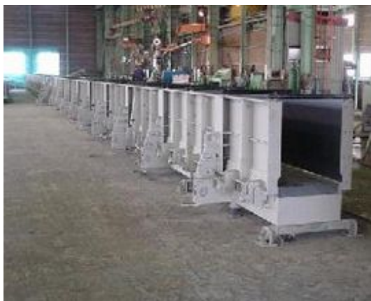
Pca用型枠 (組立時)
