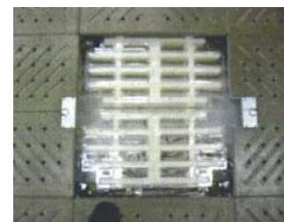
床下に設置された潜熱蓄熱材
