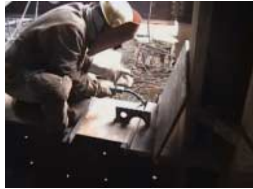
写真 - 3.5.5 工事現場における溶接作業状況(左:下フランジ、右:上フランジ)
