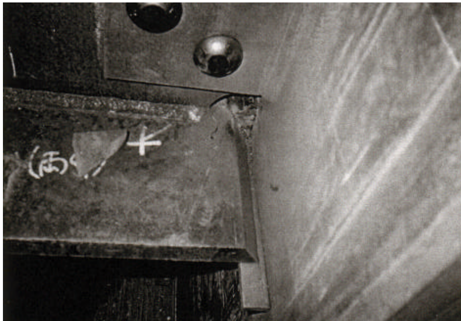
(写真4) 梁下フランジ現場溶接作業
