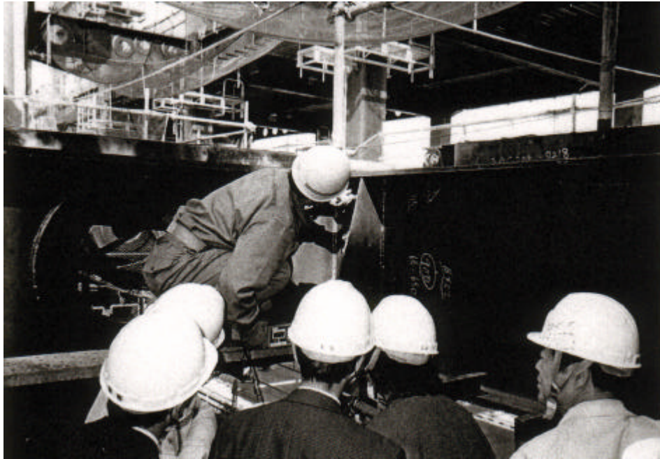
(写真7) 超音波ボルト軸力計によるボルト軸力の測定 高力ボルトのナットの対辺間での超音波の伝達速度により導入軸力を計測している。 軸力は約20トンであった。
