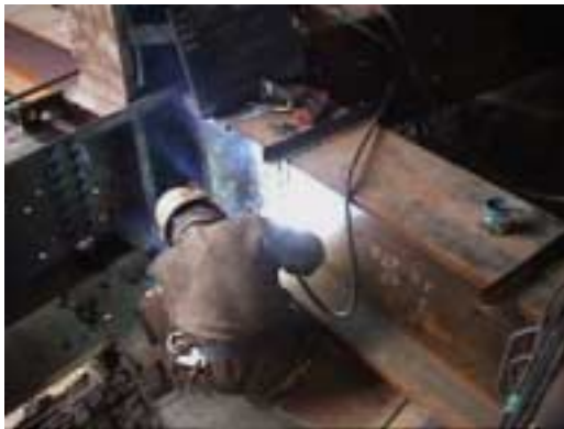
写真 - 3.5.5 工事現場における溶接作業状況(左:下フランジ、右:上フランジ)
