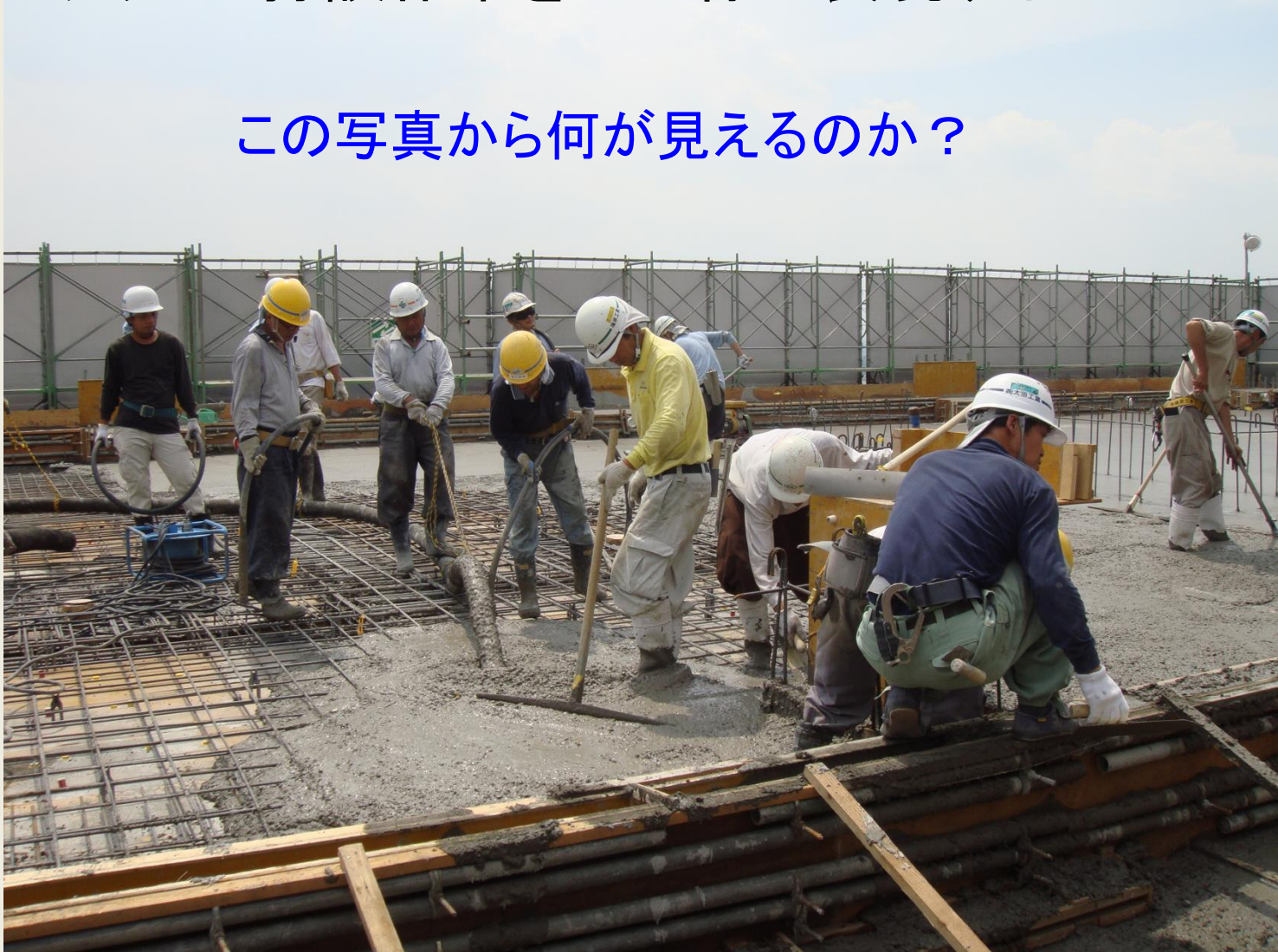
図 コンクリート打設作業
