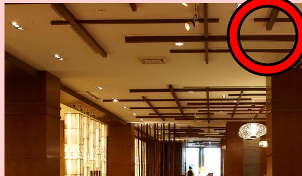
天井部分木現し
