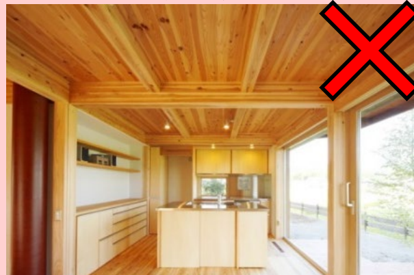
天井全面木現し
