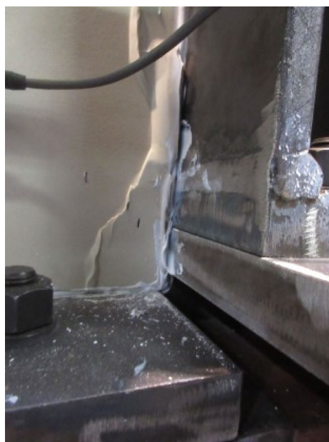
(b) ボードとフレームの接触（面内+0.75%）
