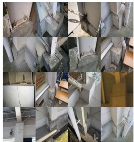
図2 鉄骨造柱脚部と定着部の画像の例
