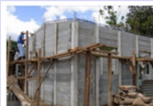
写真1 ブロックパネル造
