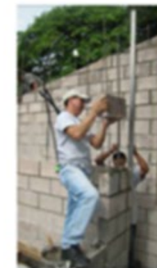
写真2 コンクリートブロック造
