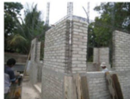
写真3 枠組組積造 (ソイルセメントレンガ)
