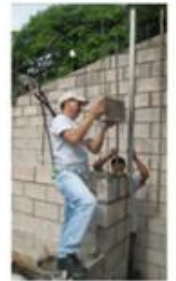
写真2 コンクリートブロック造
