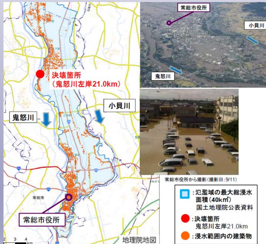
常総水害 (平成27年9月)
