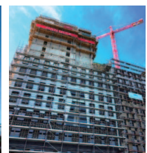
建設中の24階建事務所・ホテル等複合建築物（木・RC混構造）（ウィーン・オーストリア）
