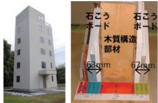
図2 建築研究所に建設された木造6階建て耐火構造建築物（試験体）
