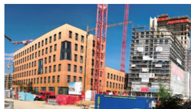
建設中の24階建事務所・ホテル等複合建築物（木・RC混構造）（ウィーン・オーストリア）
