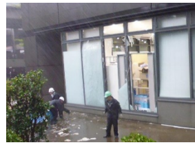
庁舎A 1階東面開口部ガラスの破損と1階南面の軒天井の持ち上がり
