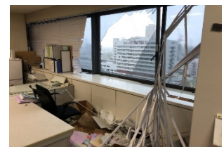
庁舎A 1階東面開口部ガラスの破損と1階南面の軒天井の持ち上がり
