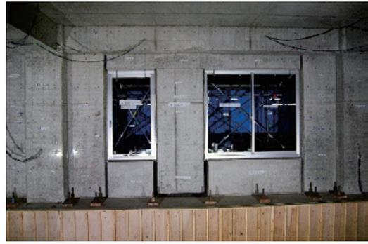
写真IV-1 窓サッシ取付状況 (X0-X1間)
