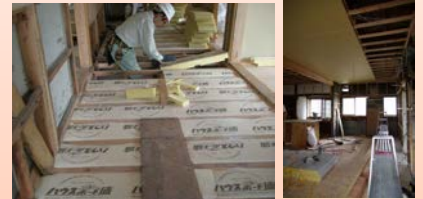
写真1 木造住宅の改修工事の現場
