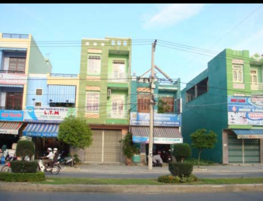
隣と密接して建てられた、通風、採光のほとんど取れない、現状のチューブハウス
