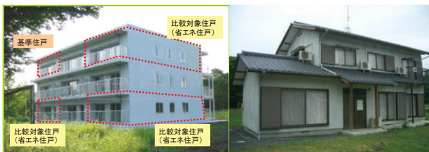
図7 建築研究所に建つ実働効率試験のための実験住戸 (左: 集合住宅、右: 戸建て住宅)
