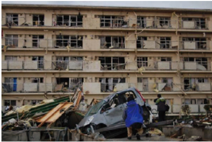
写真 22 集合住宅(南面)の被害状況 (つくば市)
