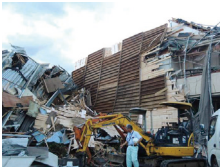
写真 29 飛来物(上部構造)の衝突 (越谷市)
