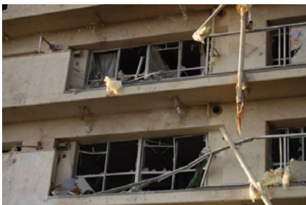
写真 23 窓とベランダ手すりの損壊 (つくば市)
