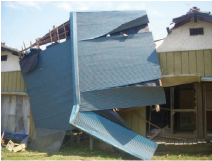
写真 28 飛来物(屋根)の衝突 (つくば市)
