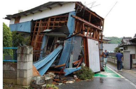
写真14 上部構造の水平移動（つくば市）
