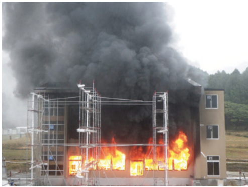
写真7 2階教室に延焼 (83分後)
