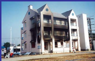
3階建て共同住宅の実大火災実験
