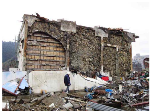
写真7 塀を乗り越えた2階建て建築物
