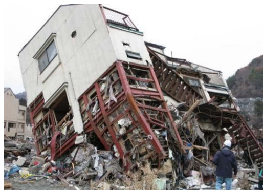
写真21 3階建てS造の1階柱脚部の引き抜けおよび1階柱の座屈による転倒
