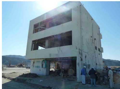
写真3 残存する3階建て建築物
