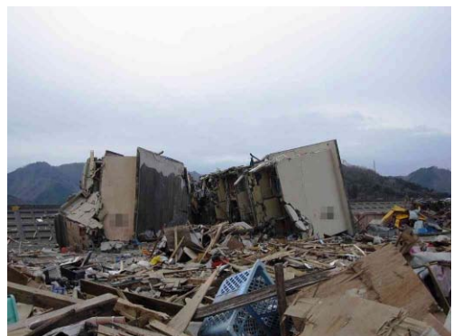
写真8 CB造集合住宅の転倒
