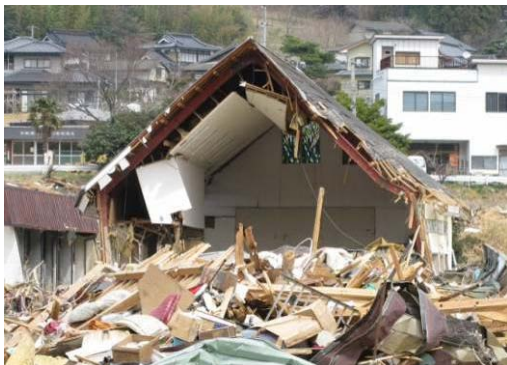
写真25 傾斜した山形ラーメン架構
