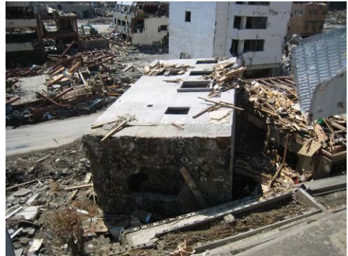
写真5 4階建て杭基礎建築物の転倒
