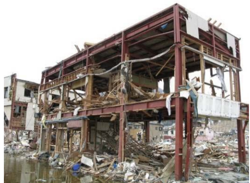
写真26 残存するS造建築物
