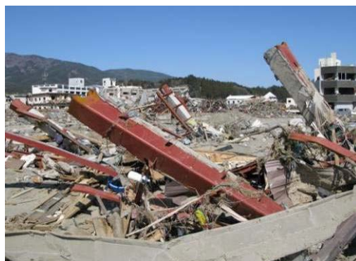
写真18 1階柱の残存
