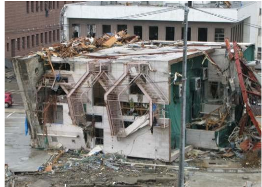
写真20 3階建てS造の転倒
