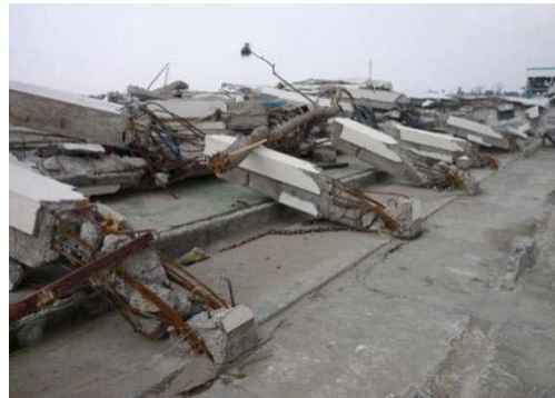
写真1 2階建て建築物の倒壊
