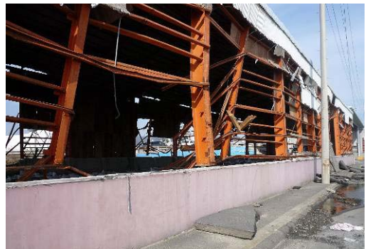
写真28 柱の変形
