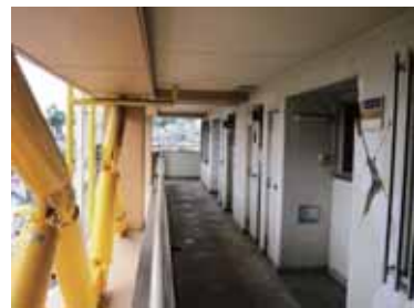
写真3-11 非構造壁(玄関側) 写真3-12 制震ダンパーで補強された建築物における非構造壁の被害
