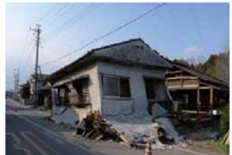
写真5-4 建築物の倒壊
