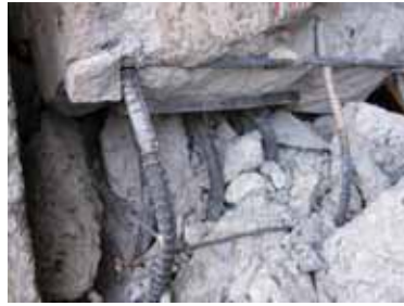
写真3-5 柱脚ベースプレート付近の主筋座屈 写真3-6 開口付き境界梁の損傷
