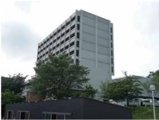
写真 2-1 東北大学内建築物の外観
