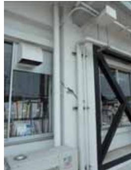
写真3-9 補強後の柱のせん断ひび割れ 写真3-10 応急補強した柱の被害
