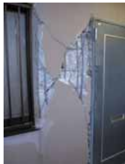
写真3-11 非構造壁(玄関側) 写真3-12 制震ダンパーで補強された建築物における非構造壁の被害
