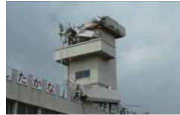
写真3-7 4階建て建築物の傾斜 写真3-8 塔屋の損傷及び落下
