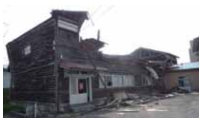
写真5-7 2層が崩壊した木造校舎
