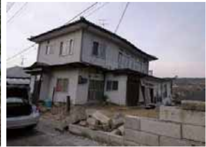
写真 5-12 敷地等の崩壊に伴う建物の被害
