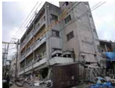
写真 3-1 1 階の層崩壊
