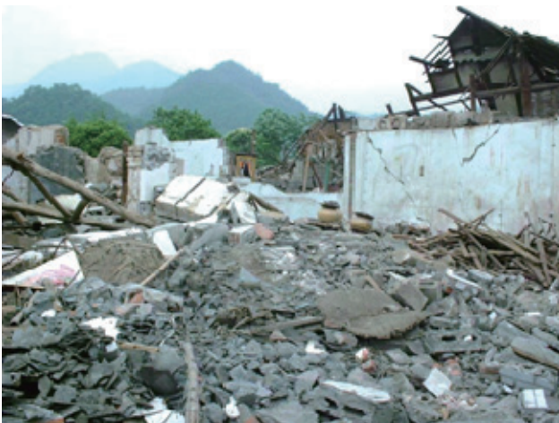
図12 木造、レンガ造の住宅の被害 2008 綿竹、四川
