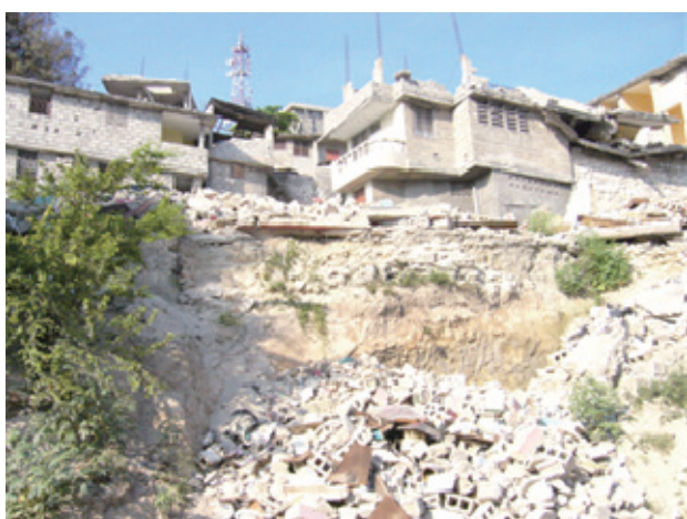
図17 住宅地の斜面崩壊 2010 ハイチ (CODE 提供)
