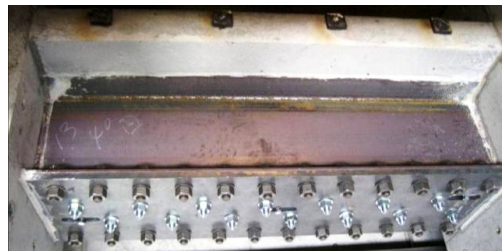
鉄骨梁による補強
