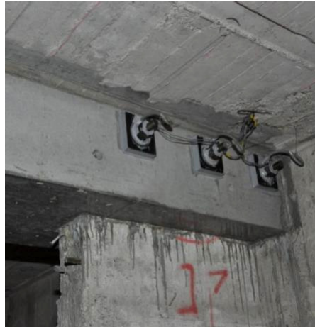
PC鋼棒の圧着による接合
