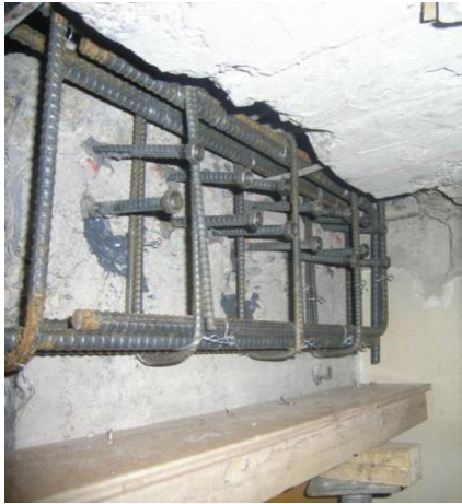
あと施工アンカーによる接合
