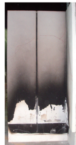
図7 Case2（外断熱） （実験後の外装表面）
