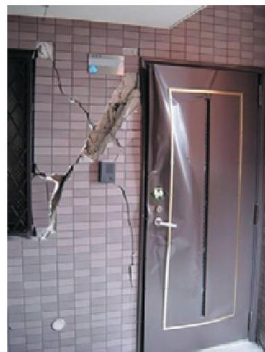
写真2 平成17年福岡県西方沖地震における共同住宅の廊下側非構造壁のひびわれ損傷
