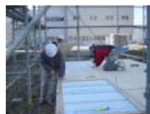
写真2 404材の床根太と実合板による床の施工
