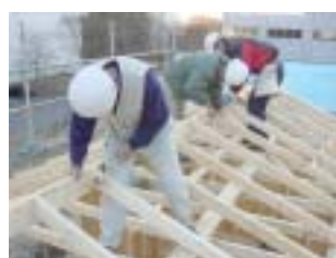
写真1 ビス釘による枠材間の接合
