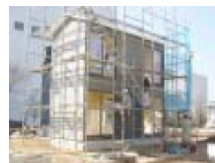
写真8 分別・解体容易な枠組壁工法建物のプロトタイプ
