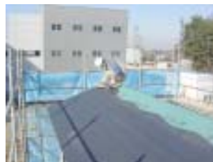
写真3 ビスによる屋根葺き材の留め付け
