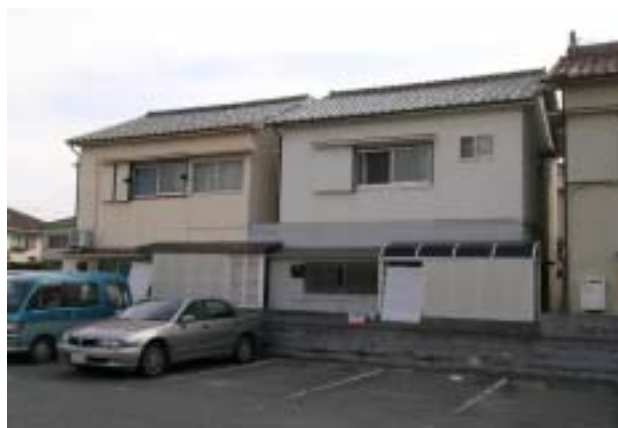
写真1 明石H邸移築前の外観（左がB棟、右がA棟）
