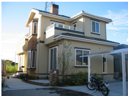
図4 対象戸建住宅の外観 (提供: ㈱一条工務店)
