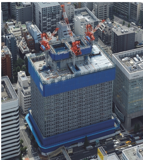
RC コアウォール+ ハイブリッド・ペリメーターフレーム
