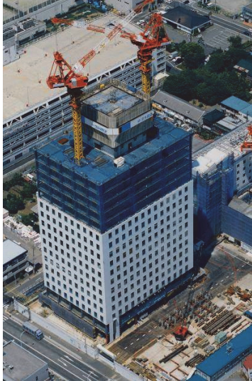
RCコアウォール+ 外周鉄骨フレーム
