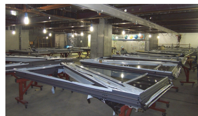
地下サイトファクトリーにおける部材の連結
