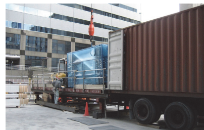
カーテンウォール部材のコンテナによる搬入
