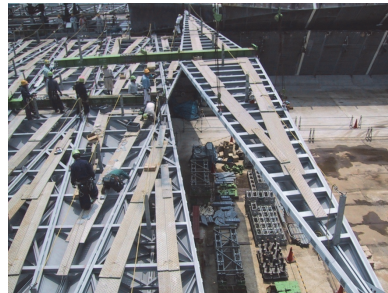
セッティングビームを利用した折板の無支柱施工
