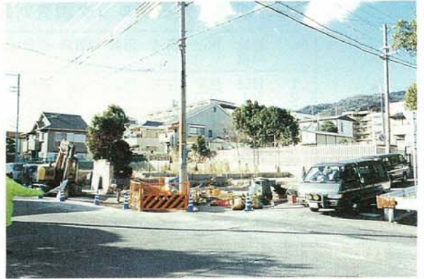
写真3.2.3.18 ブロックの復旧後の状況 (同左、1996年1月)
