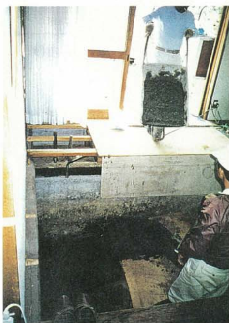
写真3.2.3.37 N氏宅 コンクリート打設
