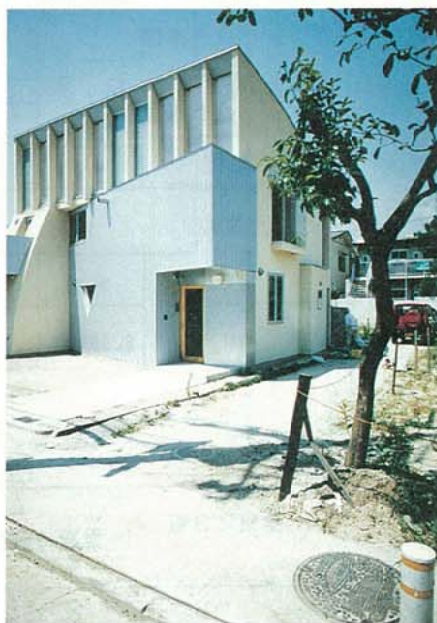
写真3.2.3.52 K動物病院 工事完了後全景
