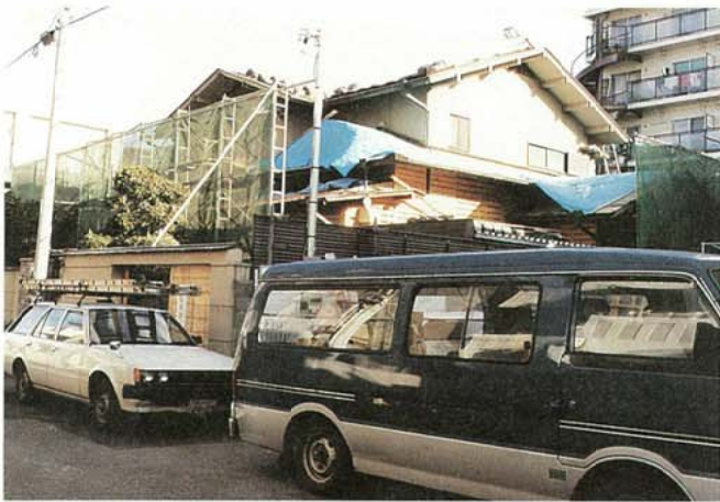
写真3.2.3.55 Y氏宅 復旧工事中
