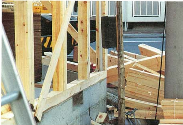
写真3.2.3.25 新築土台例（在来構法3階建て、ホールダウン用アンカーボルト）
