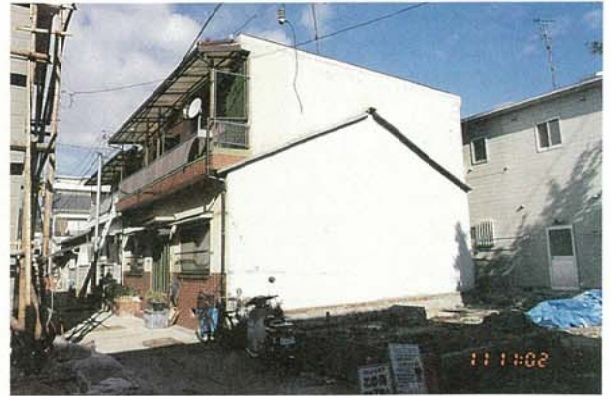
写真3.2.3. 4 [復旧事例、長田1] 補修による復旧状況
