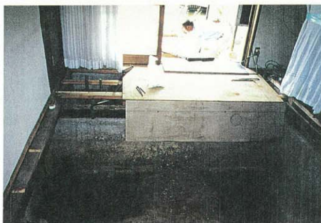
写真3.2.3.38 N氏宅 杭頭から基礎下へH鋼挿入
