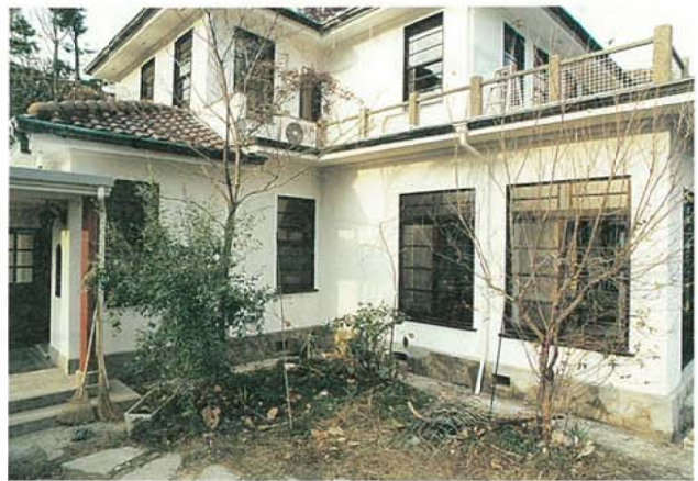
写真3.2.3.46 K氏宅 工事完了後全景
