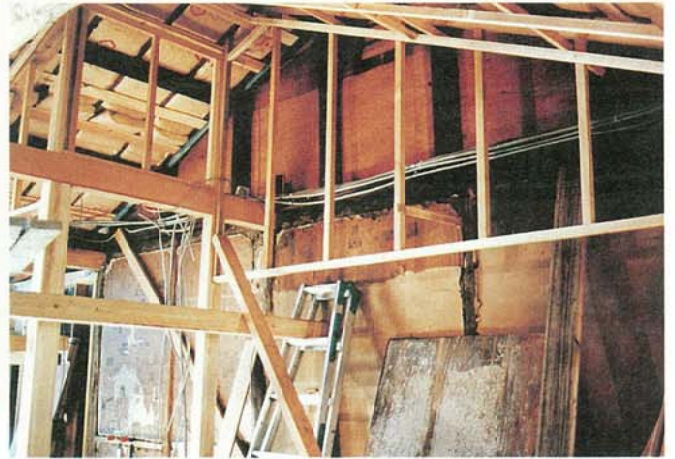
写真3.2.3.60 隣家との境壁と小屋組
