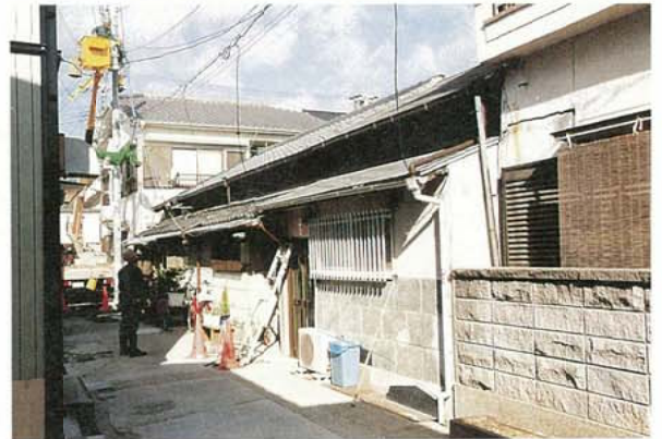
写真3.2.3. 6 [復旧事例、長田2] 補修による復旧状況
