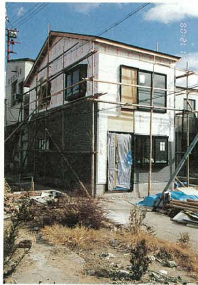
写真3.2.3. 10 [復旧事例、長田3] 再建 (新築) による復旧状況
