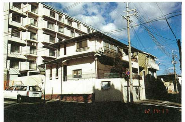
写真3.2.3.22 〔復旧事例、本山2〕 補修後の現在の状況 (1996年1月)
