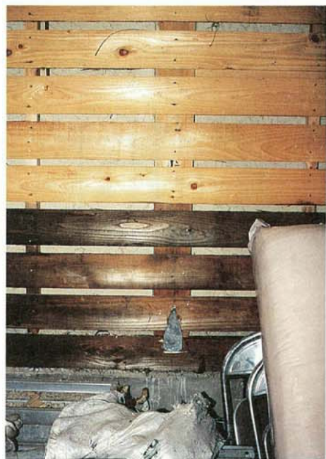
写真3.2.3.56 Y氏宅 西側外壁柱脚、 山形プレート取り付け
