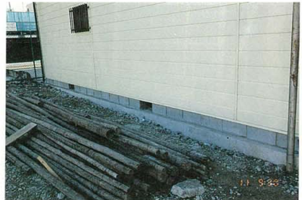
写真3.2.3.26 新築基礎例（一部にコンクリート製ブロック）
