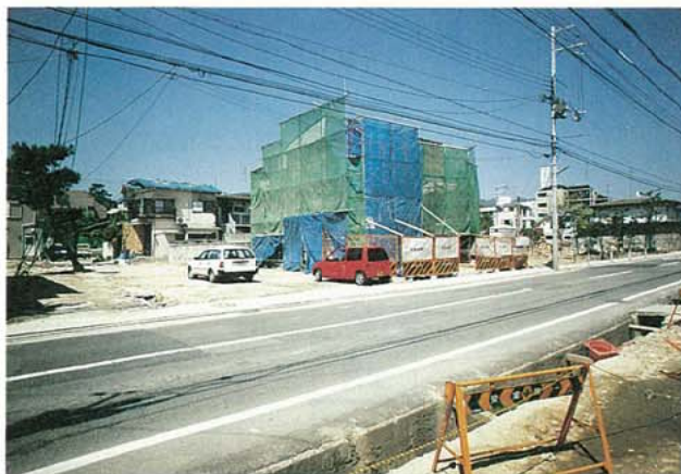
写真3.2.3.47 K動物病院 震災後全景
