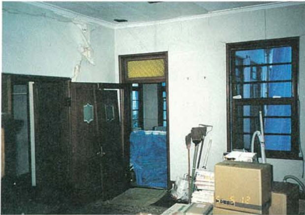
写真3.2.3.43 K氏宅 玄関ホール補修前
