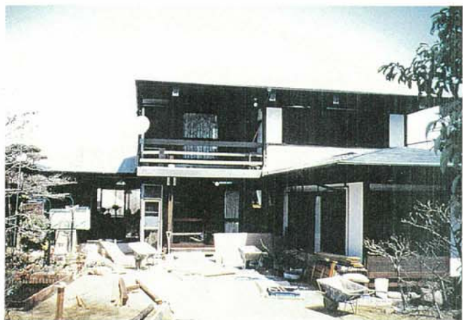
写真3.2.3.35 N氏宅 工事開始直後全景
