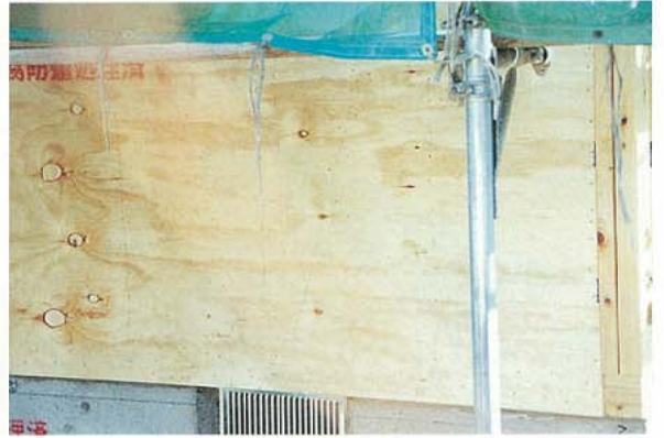
写真3.2.3.30 新築建物の筋かい（合板の上から筋かいに釘打ち） ↓筋かい位置
