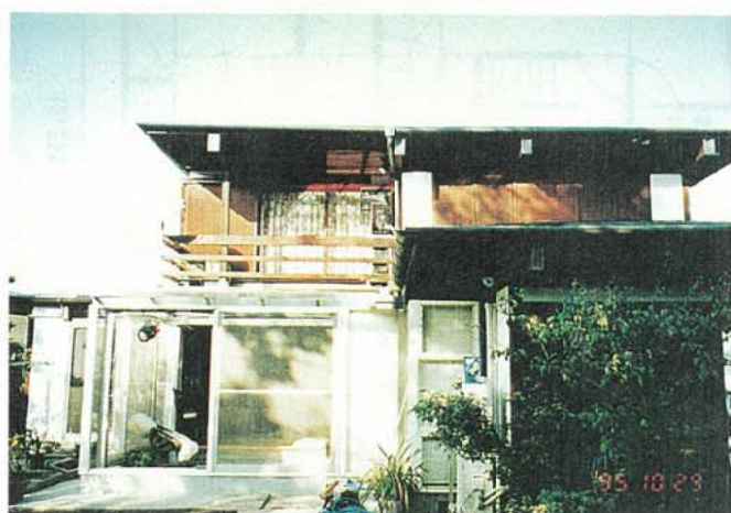
写真3.2.3.40 N氏宅 工事完了後全景
