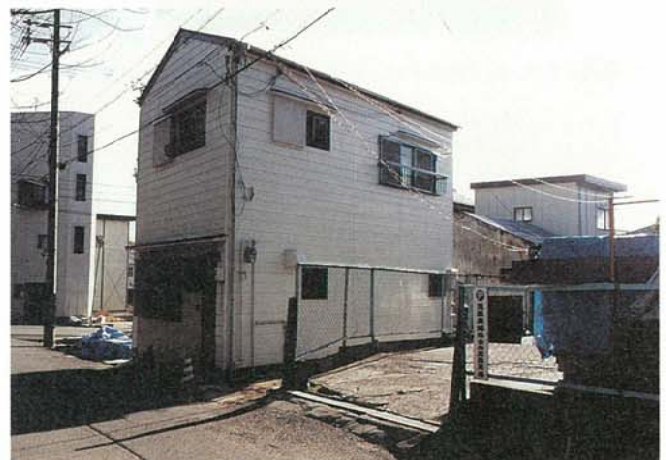
写真3.2.3.16 [復旧事例, 大石2] 復旧状況 (1996年1月)
