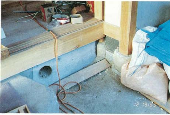
写真3.2.3.23 基礎補強例（束石間に鉄筋コンクリート造布基礎を打設）
