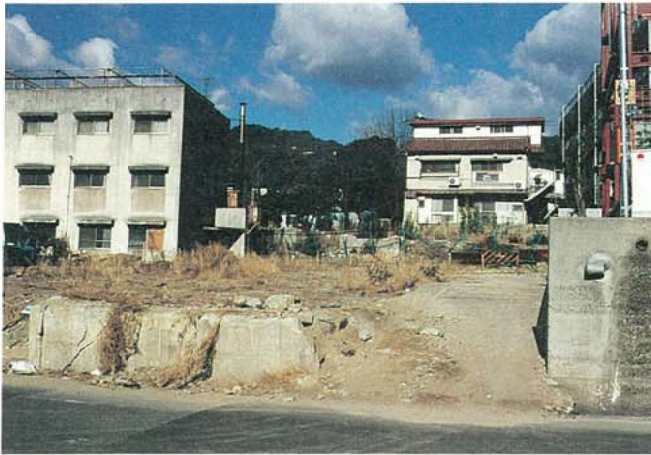
写真3.2.3.11 復旧状況 (灘区大石北町, 1996年1月)
