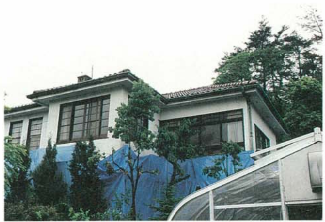
写真3.2.3.42 K氏宅 工事開始直後全景
