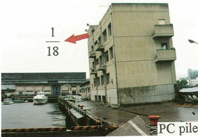
写真3.2.4.5 側方流動によりP C杭が破壊したため傾いた 3階建R C造建物
