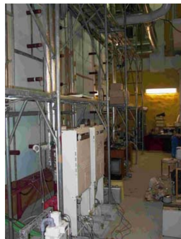
図 1 建築研究所内の人工気候室の様子
