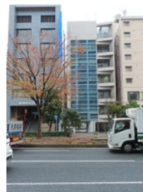
写真2 地震計設置建物と無線式地震計
