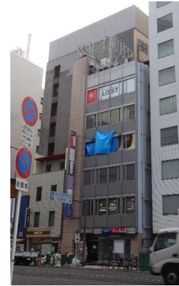
写真-I-1. 2. 2 火災によるビルの被害状況
