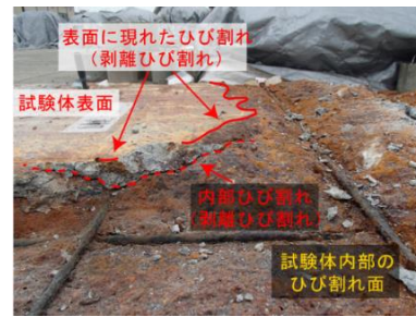
写真2 強制腐食試験後のひび割れの観察
