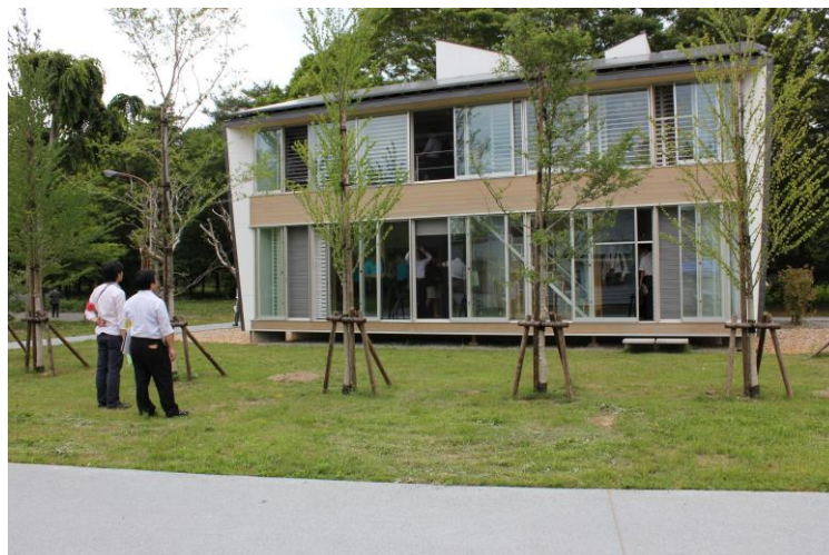
写真-I-1. 2. 8 LCCM デモンストレーション棟
