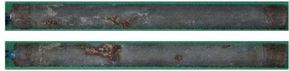
写真1 鉄筋腐食状況(茨城・雨掛かりあり・ばくろ3年)
