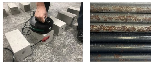
図5 腐食診断器による測定と内部の鉄筋
