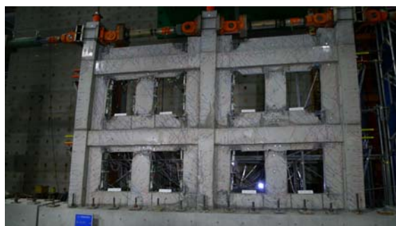
写真2 補強された壁付き架構加力実験
