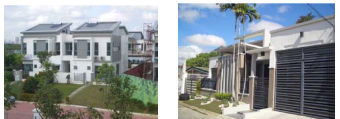
(写真) 現地の様子 (左) マレーシアの建設中の分譲住宅地 (右) フィリピンの住宅地
