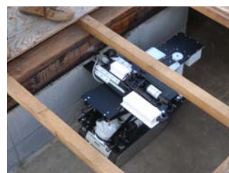
写真2 劣化診断装置の使用性調査
