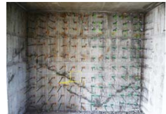
写真2 実建物実施工による条件の各種施工精度と付着強度の確認
