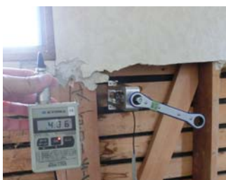
写真1 木造住宅の劣化度調査
