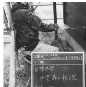
写真2 外壁塗装の施工（写真：浜松市提供）
