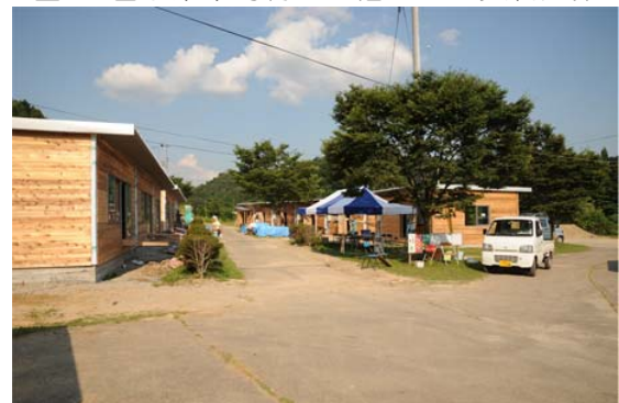
図3 地元工務店建設の木造仮設 (三春町)
