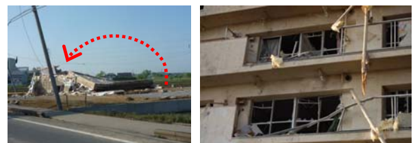
(c) 住宅上部構造の転倒 (d) 集合住宅建具の著しい損壊
