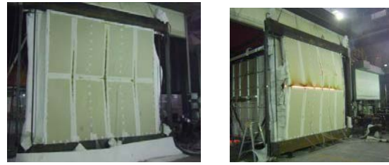
a) S2 (熱応力) b) S4 (強制変形) 図 6 熱応力・強制変形時の損傷状況
