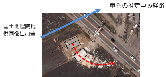
(a) 図 3(c) に示す木造住宅の被害状況
