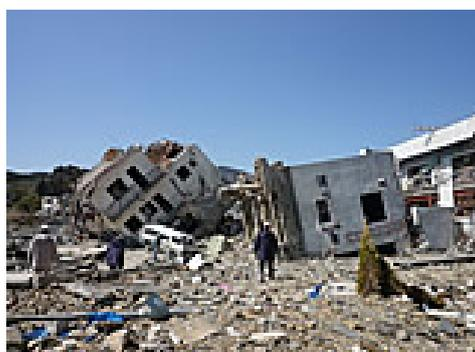
写真一．4．1．2 津波による被害建築物
