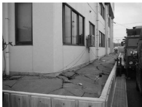
図1 直接基礎建物の基礎と周辺地盤のすべり
