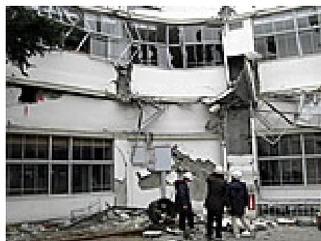
写真一．4．1．3 地震による被害建築物
