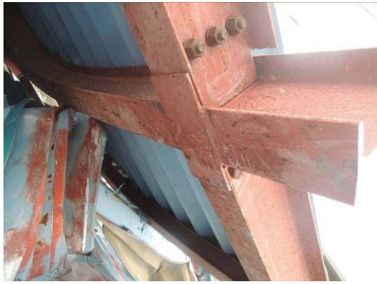
写真 15 鋼製屋根の下面
