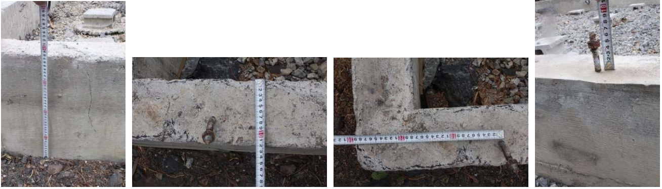
写真 10 布基礎各部の寸法
