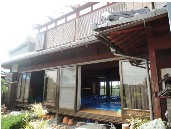
写真5 1階南面での開口部の状況
