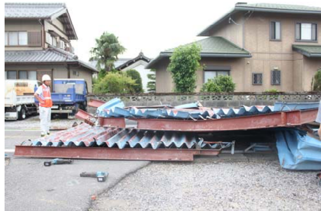
写真 14 鋼製屋根の状況
