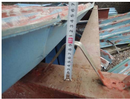
写真 17 鋼板製折板ぶきのタイトフレーム
