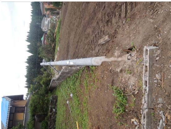
写真 29 電柱の折損
