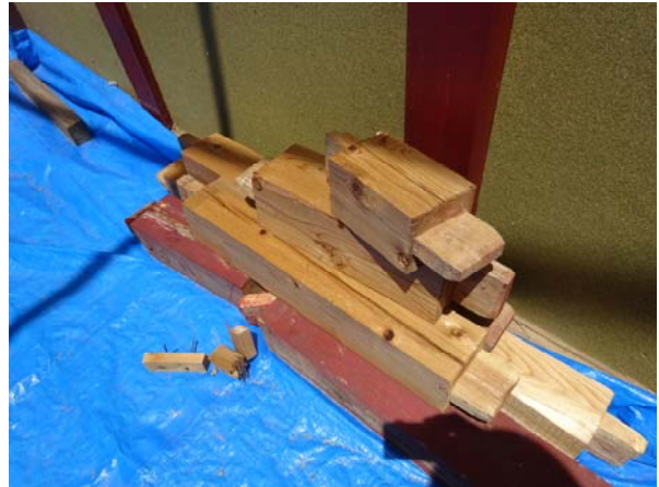
写真3 飛散した屋根の小屋束
