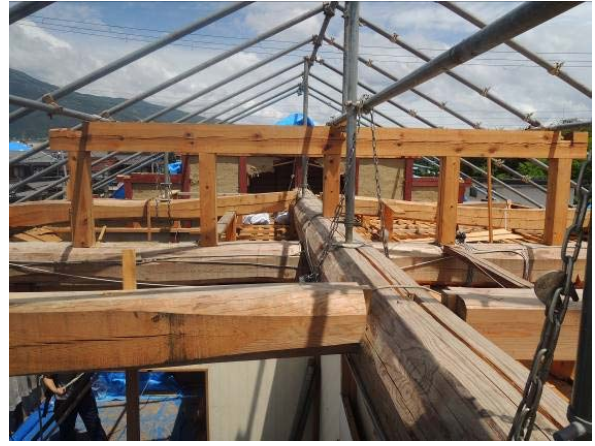
写真2 小屋組の状況
