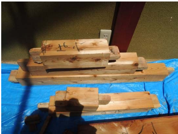
写真3 飛散した屋根の小屋束
